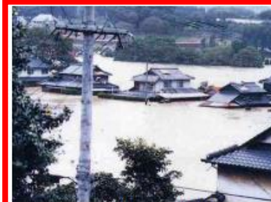
写真 1.2.9 本川 14.2km 付近の浸水状況 (玉名市)
