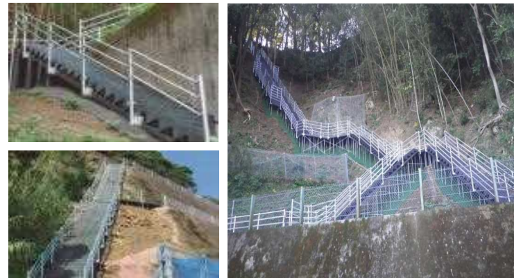
シェルターステップ (地山を削らない津波避難用階段)
