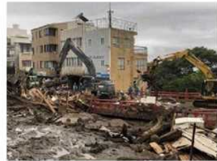
国道被災状況
