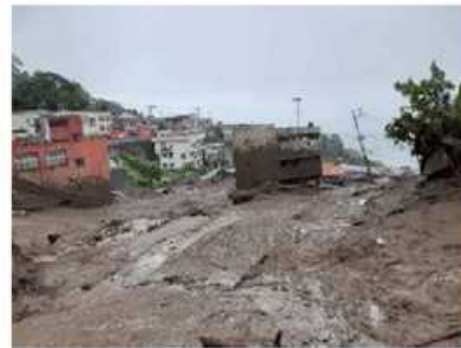
家屋被災状況
